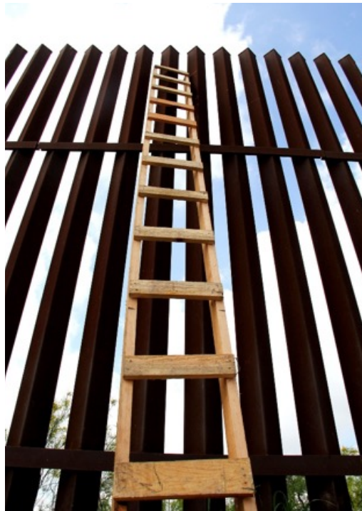
Una escalera en el muro en el sur de Texas |
